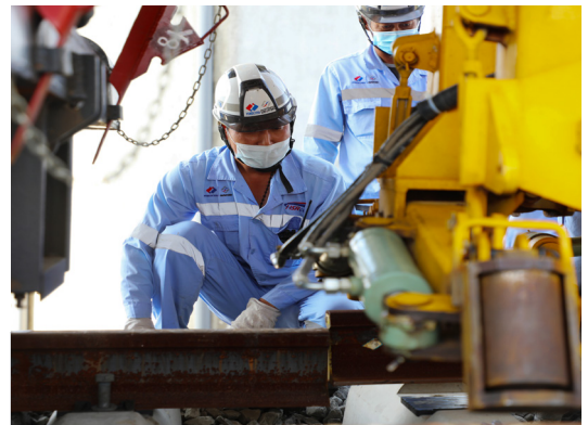
Photo montrant des ouvriers sur le chantier de construction de la voie ferrée, sur la ligne principale du chemin de fer à grande vitesse Jakarta-Bandung, à Bandung, en Indonésie, le 1 er juillet 2022 (XINHUA)
